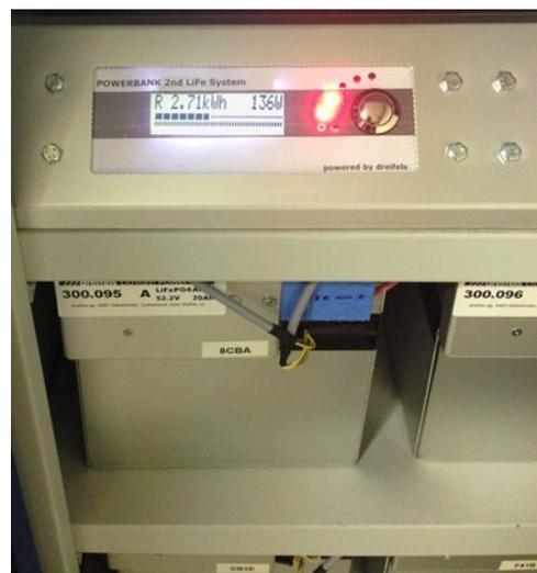
Abbildung 18: PMU Batteriemanagement oben und Akkublock darunter.
