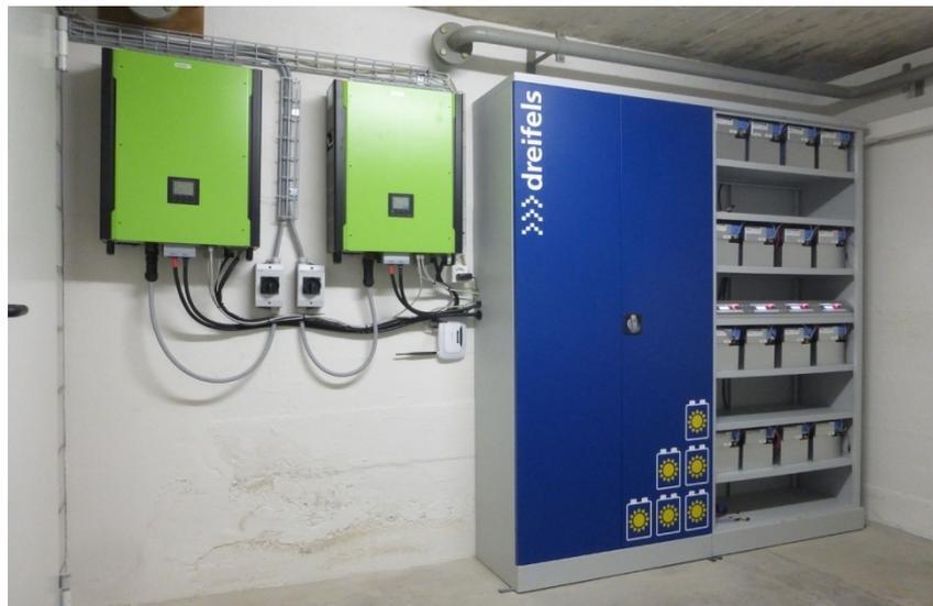
Abbildung 17: Batteriespeicher im UG des Kohlesilos (Quelle: Dreifels, Gelterkinden).
