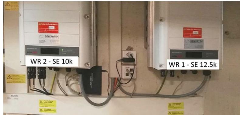
Abbildung 14: Solaredge Wechselrichter WR 1 (Dach) und WR 2 (Fassaden). (Quelle: Fabio Rui)
