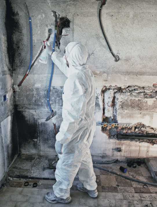
Kein Grund für einen Schrecken: Sanierer mit Suva-konformer Ausrüstung. (Bild: Kuster Frey Fotografie)
