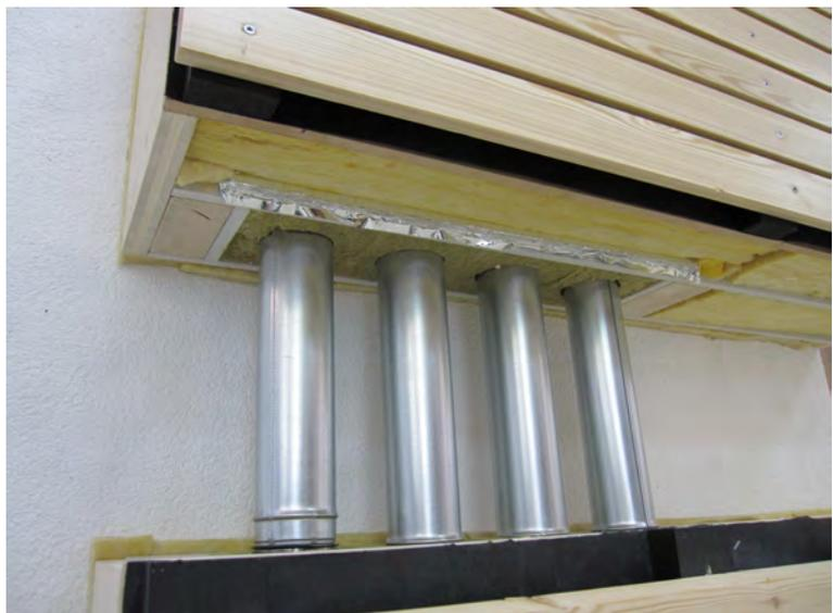
**Abbildung 21: F4.1 Modul, mit eingesteckten Lüftungsleitungen**
