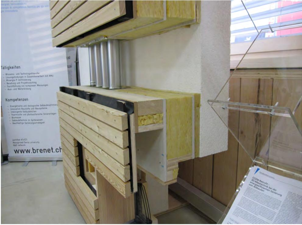
Schnitt Ansicht im Storenbereich, hinterlüftete Fassade
