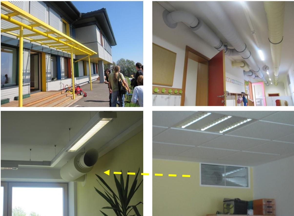
Abbildung 8: Oben links: erneuertes Schulgebäude „Volksschule Sörg“ in Österreich / oben rechts: Die Lüftungsrohre für Zuluft sammeln sich im Korridor / unten links: Überströmung der Klassenzimmer- Abluft in den Korridor / unten rechts: Abluftfassung im Klassenzimmer
