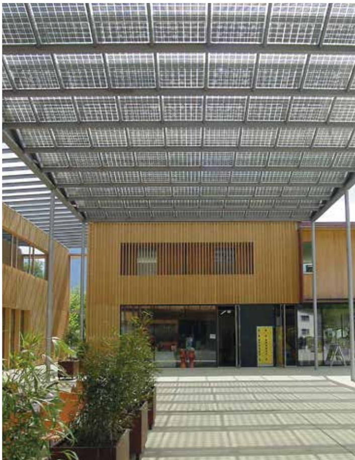
*Abbildung 105: Berufsschule in Wolfhagen (Deutschland), Überdachung mit ASI-THRU-Module (Schott) mit integriertem Sonnenschutz. Deutscher Solarpreis 2011.
