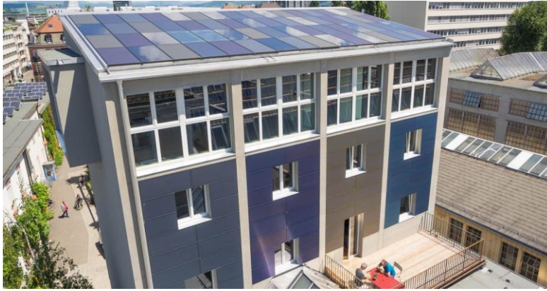
Abbildung 10: Ansicht Südfassade und Dachanlage. Quelle: Martin Zeller
