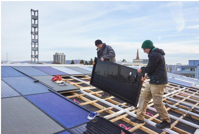
Abbildung 9: Montage der dachintegrierten PV-Anlage, Unterkonstruktion System Mecosun. Quelle: Martin Zeller
