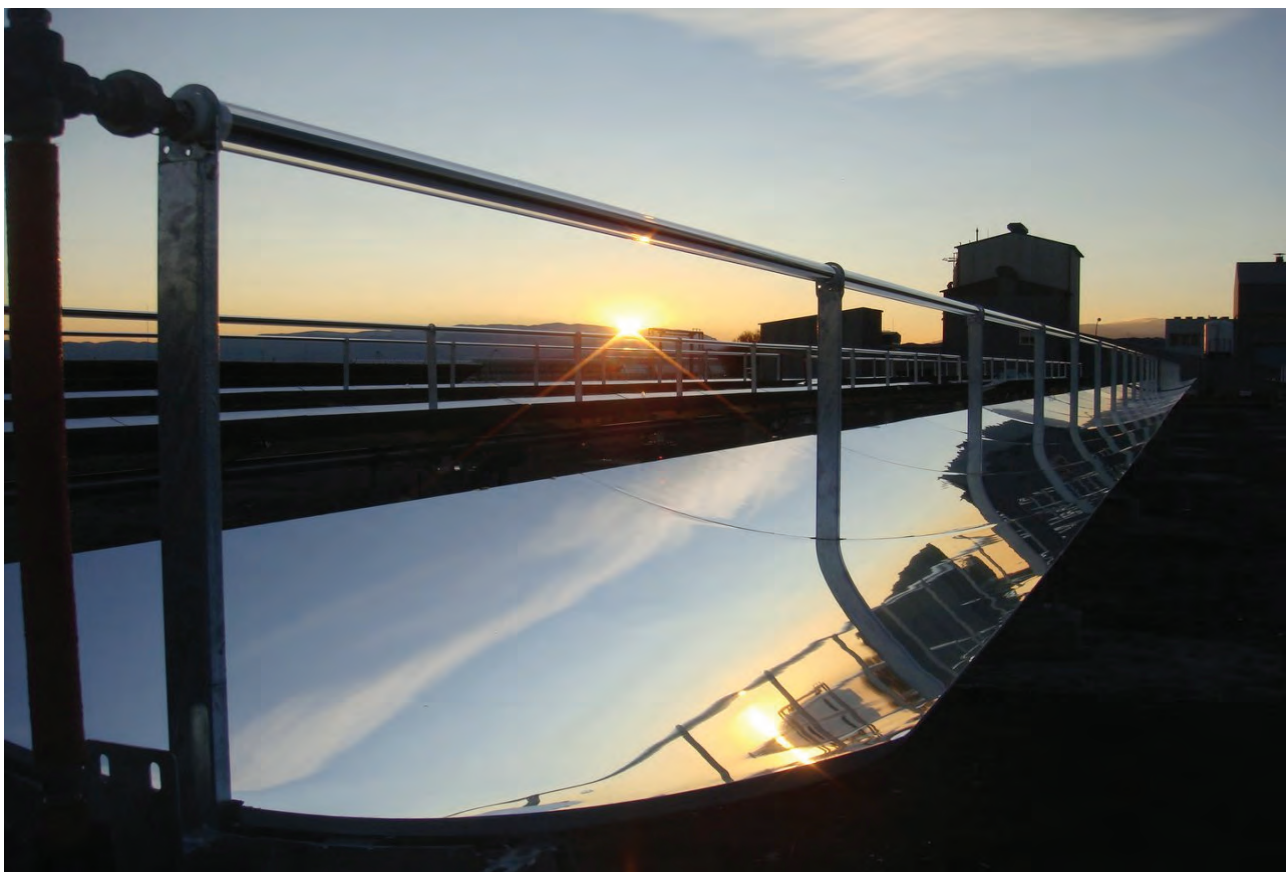
Abbildung 3: Solaranlage in Almeria
