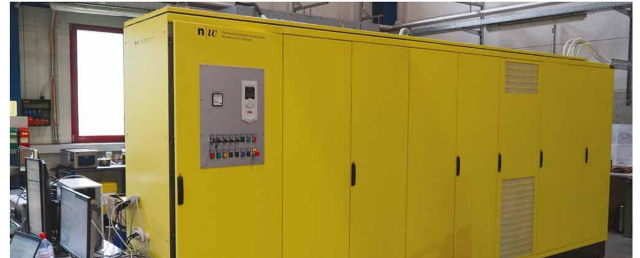
Abbildung 2: Die Einspeisung, Zwischenkreisnetzgerät, 12 Umrichter der Motoren sowie Komponenten der Steuerungs- und Regelungstechnik wurden in einem rund 8m langen Schaltschrank eingebaut.
