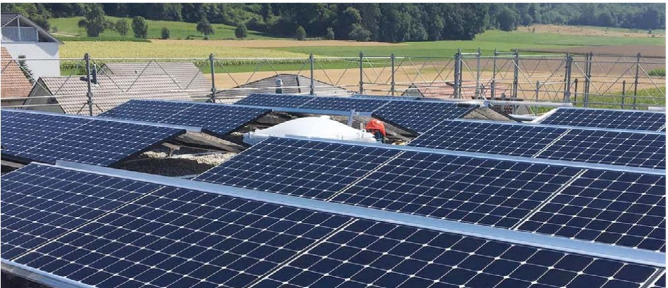
Abbildung 1: Ausschnitt aus einer Dach-PV-Anlage. Die ganze Überbauung, Dächer, Fassaden und Brüstungen hat eine PV-Leistung von über 160 kWp. Die erwartete Jahresenergieproduktion ist damit etwas grösser als der geplante Energieverbrauch der Überbauung.
