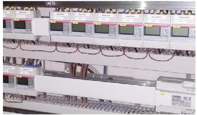
Abbildung 2: Ein Blick auf eines der Elektrotableaus. Neben allen Temperaturmessgeräten und Wärmehzählern sind gegen 80 elektrische Energiezähler installiert und mit einem Bussystem an die zentrale Steuerung der Strombörse angeschlossen. Die Rohdaten dieser Energiezähler stehen für die Messüberwachung der Anlage zur Verfügung.
