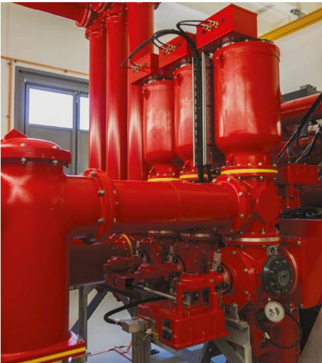
Abbildung 1: konventionelle Spannungswandler einer 110kV gasisolierten Schaltanlage
