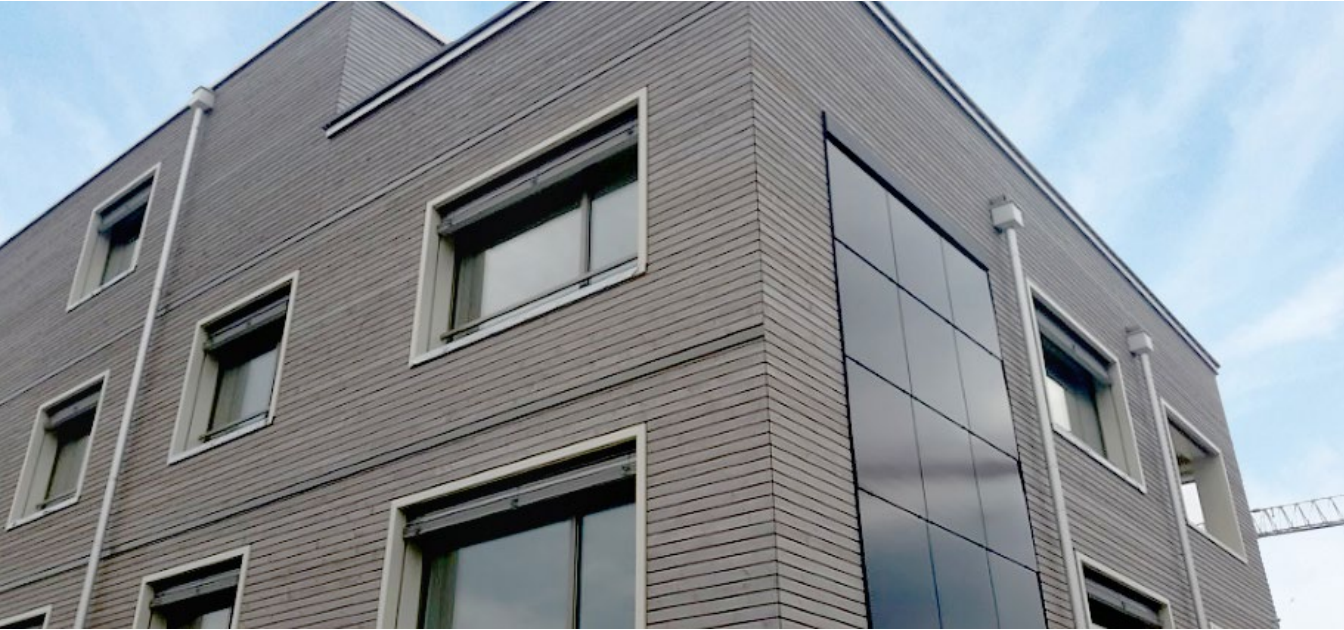
Abbildung 1: Sicht auf die Fassade eines der Gebäude. Gut sichtbar ist hier die Fassaden-PV-Anlage an der rechten Fassadenseite. Alle Dach- Brüstungs- und Fassaden-PV-Anlagen zusammen haben in dieser Überbauung eine PV-Leistung von über 160 kWp. Die erwartete Jahresenergieproduktion ist damit etwas grösser als der geplante Energieverbrauch der Überbauung. Wir reden hier also von Plusenergiehäusern.
