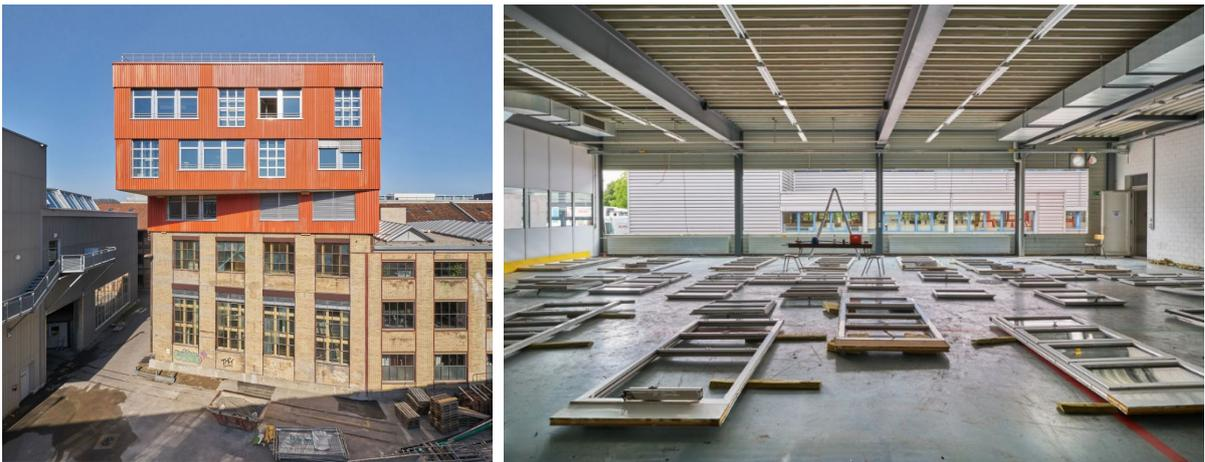
Abbildung 73: Links: Aussenansicht Aufstockung Kopfbau Halle 118, Lagerplatz Winterthur. Rechts: Re-Use-Fenster werden vor der Montage sortiert. Bilder: Martin Zeller
