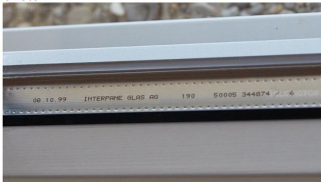
Bei den Fenstern handelt es sich um Renovationsfenster «Aluba classic» mit Holz-Aluminium-Rahmen des Herstellers 4B mit 2-IV-Wärmeschutzgläsern der Interpane Glas AG aus dem Herstellungsjahr 1999. Der Typenaufdruck im Glasrandverbund eines Fensters zeigt das Herstellungsdatum 08.10.1999.
