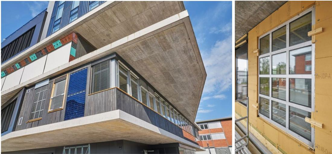
Abbildung 75: Links: Fassadenansicht UNIT SPRINT im NEST. Rechts: Montage gebrauchter Fenster mit ertüchtigter Verglasung. Bilder: Martin Zeller
