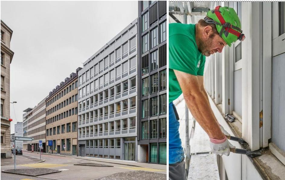
Abbildung 76: Links: Strassenansicht Bürogebäude Dufourstrasse 38 in Basel nach der Fassadensanierung. Rechts: Demontage der Fassadenelemente für die Ertüchtigung. Bilder: Martin Zeller.
