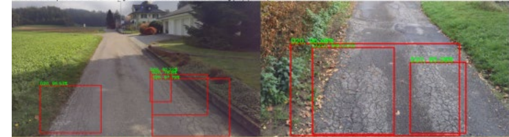
Abb. 5 und 6: Beispiele für korrekte Erkennungen auf Bildern aus der Gemeinde Lenggries (AG), (Infra3D)
