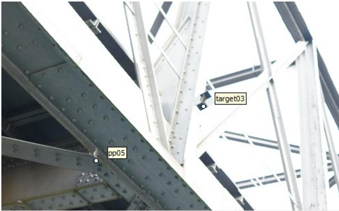
Abb. 9: Das Bild mit target02 abgebildet wird unzutreffend an der Stelle von target03 positioniert.
