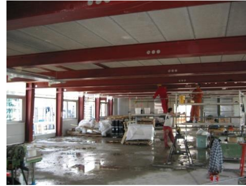
Grundierte Stahlkonstruktion nach Montage
