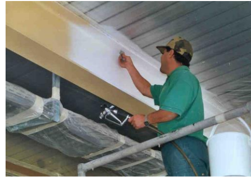
Kontrollieren der Nassschichtdicken mit dem Messkamm während der Applikation
