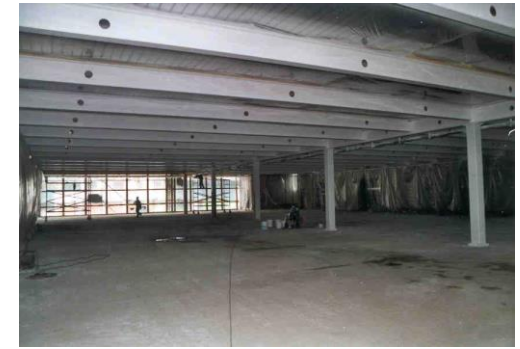
Stahlkonstruktion nach dem Aufbringen des Dämmschichtbildners
