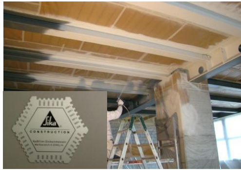
Aufbringen der dämmschichtbildenden Brandschutzbeschichtung
