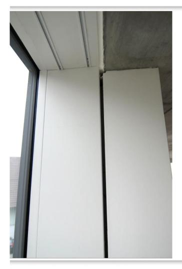
Sichtbeton-Aussenwand mit 200 – 260 mm Mineralschaum-Innendämmung
