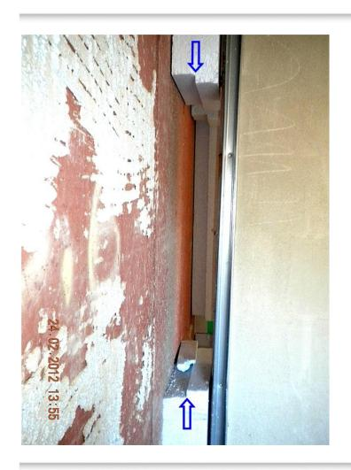
Dämmplatten mit Stufenfalz können von Vorteil sein...
