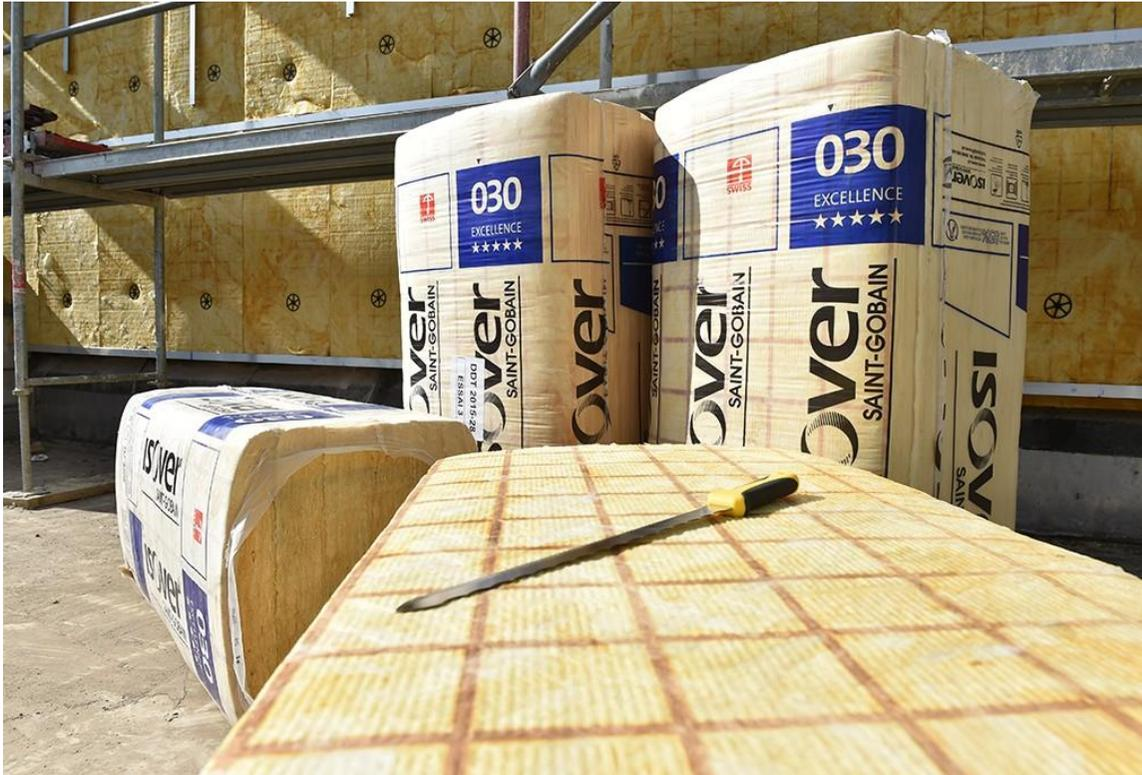
Dämmung aus Recyclingglas.
